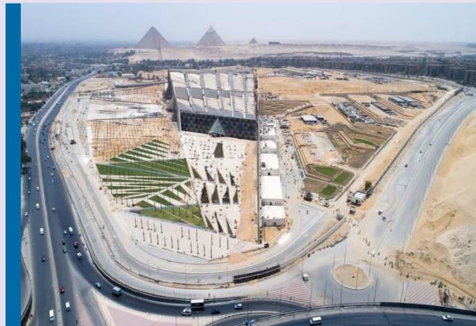
建設中の大エジプト博物館（GEM）
